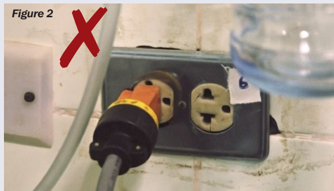
Figure 2 Adaptateur fiches tripolaire-bipolaire. À ne pas utiliser.
