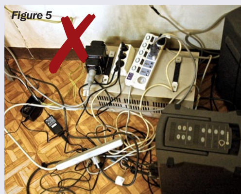
Figure 5 Ne pas mettre les prises électriques en surcharge en branchant des appareils qui excèdent la limite du circuit.
